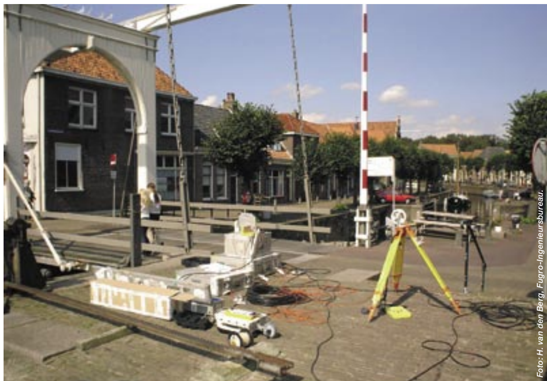
Opstelling van de boorgatradar voor de meting in Hasselt.
