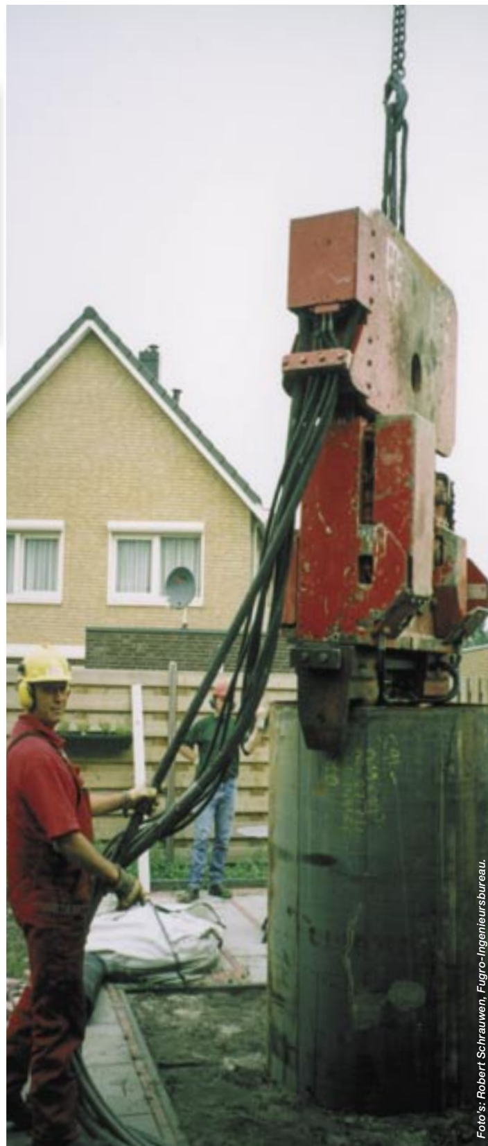
Het intrillen van de stalen buis.
